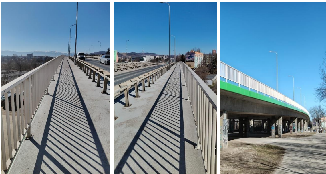
Fot. Wiadukt w ciągu Al. Jana Pawła II w Jeleniej Górze
