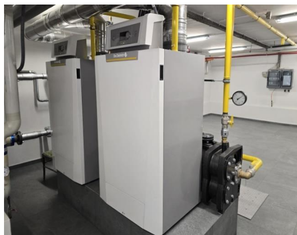
Fot. Piece kotłowni SP13 po remoncie
