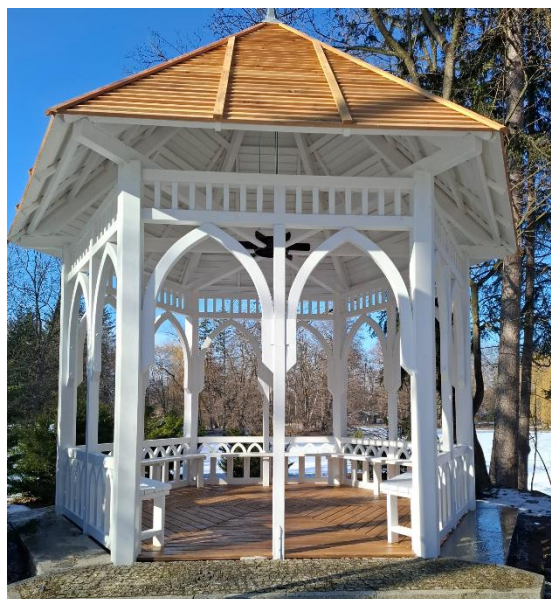
Fot. Wyremontowana altana w Parku Norweskim
