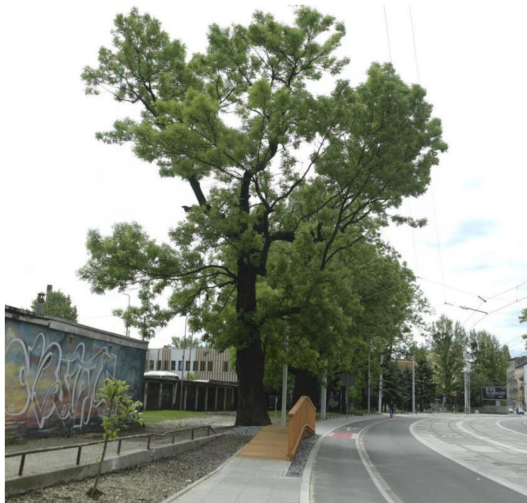
Ryc. 36 Kładka wyniesiona ponad system korzeniowy. Źródło: Zbudowali kładkę i uratowali drzewo (fakt.pl)
