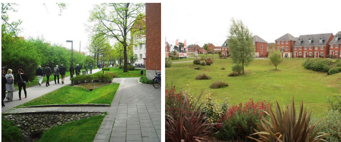
Ryc. 4 Zagłębienia infiltracyjne, źródła (od lewej): https://www.researchgate.net/figure/Drainage-system-Augustenberg-Malmoe-Sweden_fig6_251179698 ; https://developersguide.njfuture.org/what-is-green-infrastructure/large-landscape-practices/infiltration-basin/
