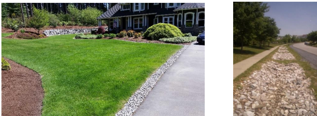
Ryc. 3 Drenaż francuski, źródła (od lewej): https://harborgreenscapes.com/drainage/french-drain/ ; https://sustainablestormwater.org/2007/05/23/infiltration-trenches/
